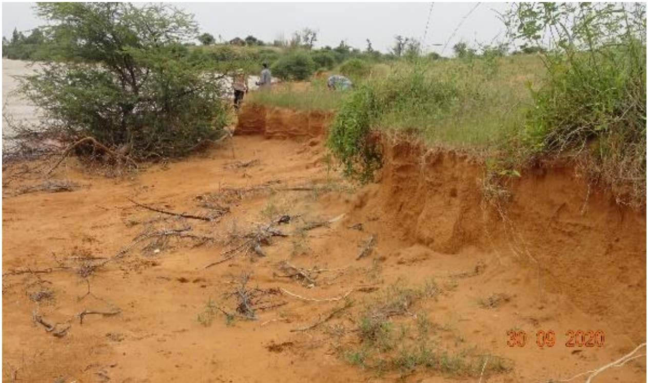
Photographie 1: Cas d'érosion des pieds de berge en rive gauche
