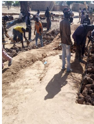
Figure 6 : Traitement de ravine à Pissila/ CLE PKTYMB
