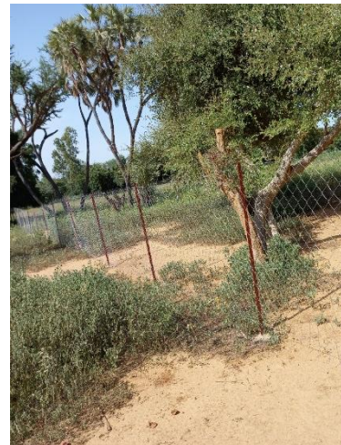
Figure 7 : Réalisation d'une clôture grillagée de 1,5 ha /CLE DAN
