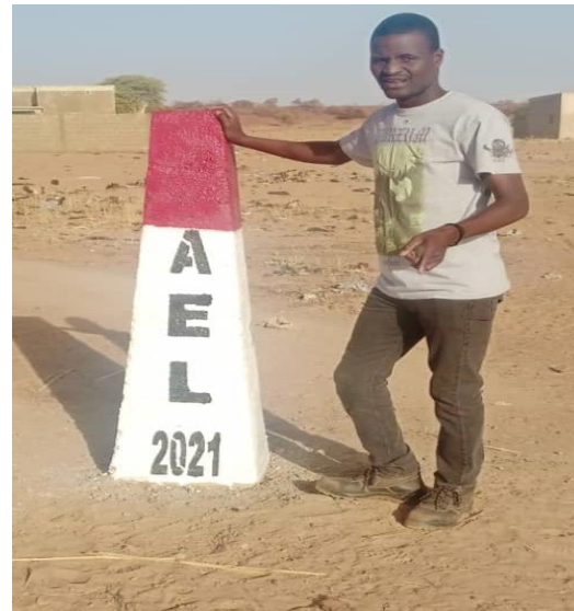
Figure 18 : Délimitation barrage de Manni/ Balise implantée sur les berges du barrage
