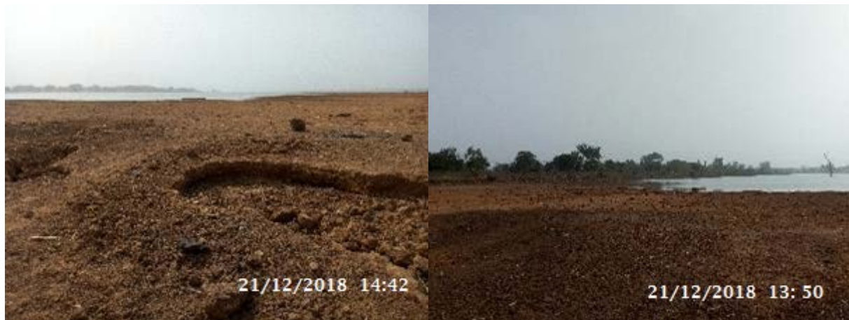
PHOTO 8 ET 9: VU DE LA CUVETTE DU BARRAGE COMBLEE
