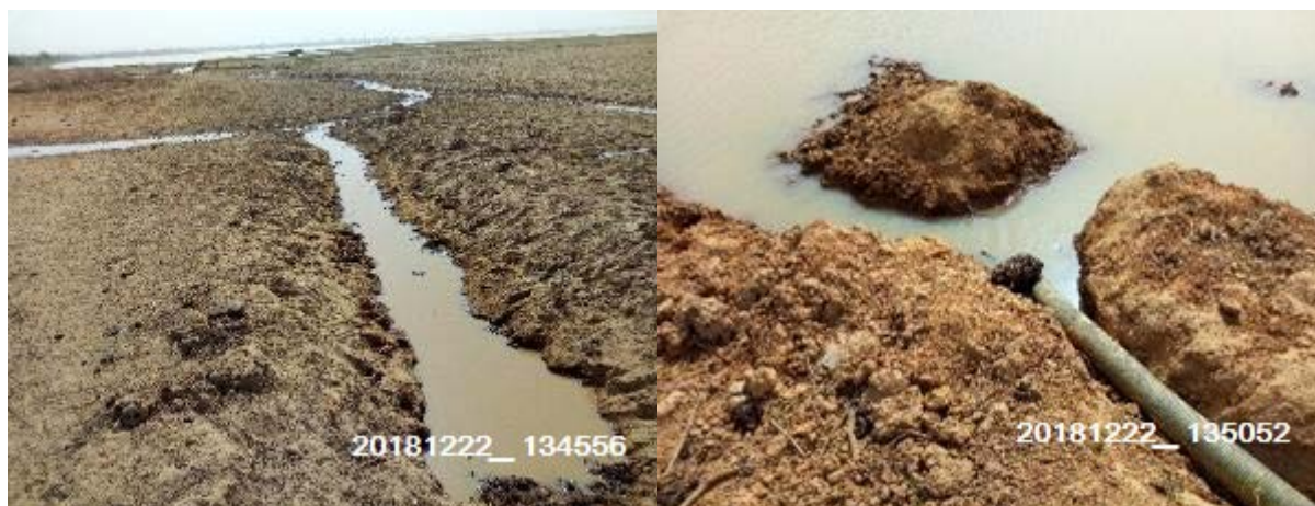
PHOTO 5 ET 6 : VU DE TRANCHEE REALISEE PAR LES MARAICHERS POUR LE POMPAGE DE L'EAU
